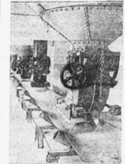
Новый хлебный элеватор в Мокше. Силосы и подсосные транспортеры.
